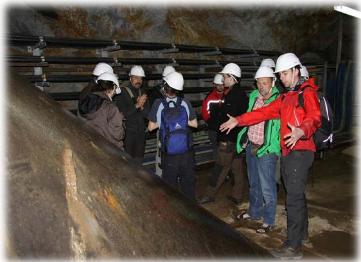
Abb. 10: Im Wasserkraftwerk Tavascan
